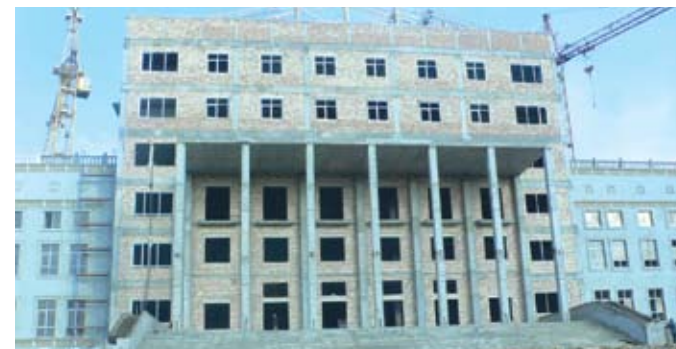
Строительство нового корпуса КазГЮУ. 2007 г.
